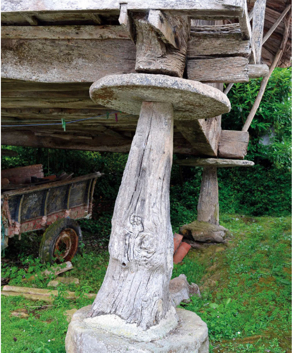
Pegollo de hórreo (Hórreos de la Ruta Capilla de Ánimas).
