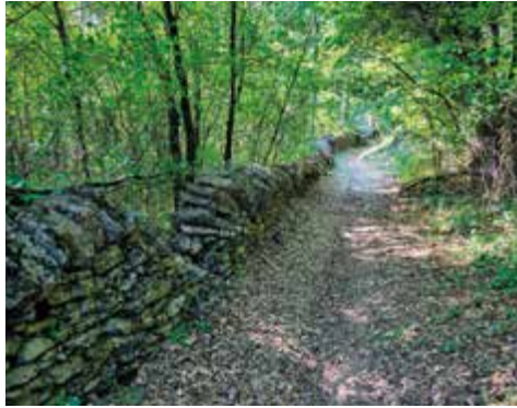
Mur de pedra seca.
